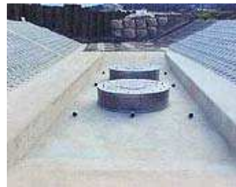
片貝町新屋敷取水施設工事 (新潟県小千谷市)／ 揚水ポンプを用い導水路に堆積した土砂等を下流方向へ掃流させる施設を用いた一例。
