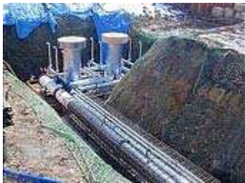
片貝町新屋敷取水施設工事 (新潟県小千谷市)／ 河川改修計画が盛り込まれ取水ストレーナーその他配管類を計画河床高に合わせられる様に工夫した一例。
