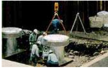
渋江川流雪溝取水施設工事 (新潟県新井市)
